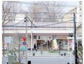
3) 富士見台トンネル(2019)
